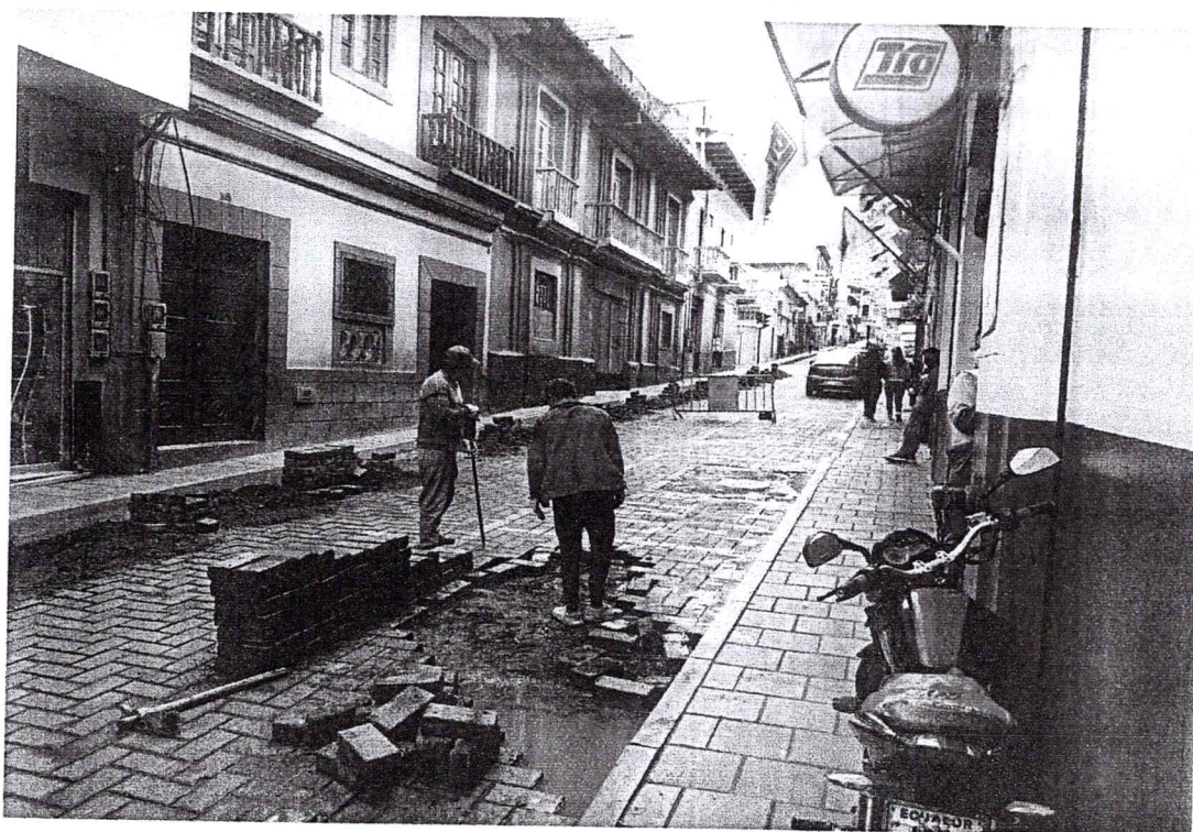
remocion manual del adoquin existente
