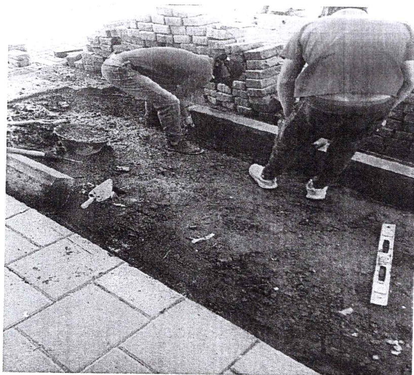
nivelacion y colocacion bordillos en la nueva posicion del ensanche de la acera
