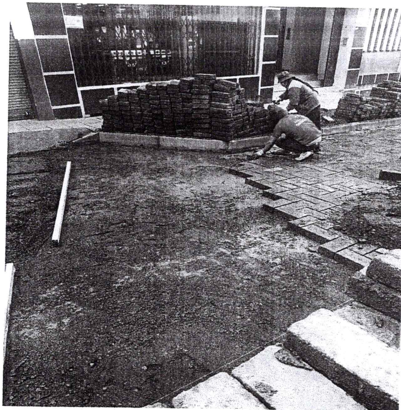
nivelacion y colcoacion de aoquines
