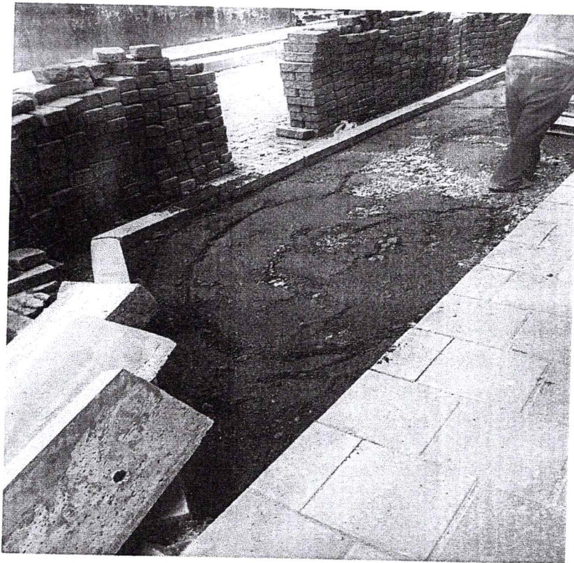
compactacion de suelo mejorado con lastre
