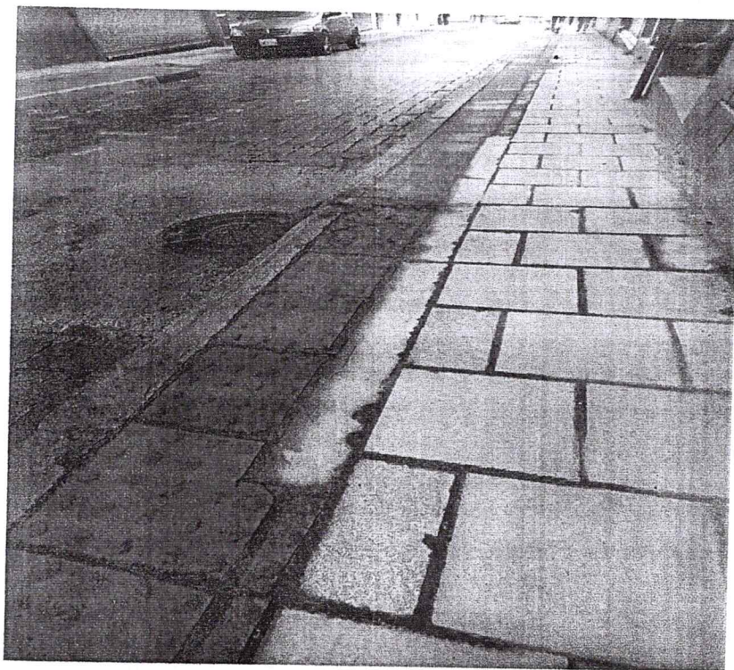
TRAMOS CON BALDOSA PODOTACTIL
