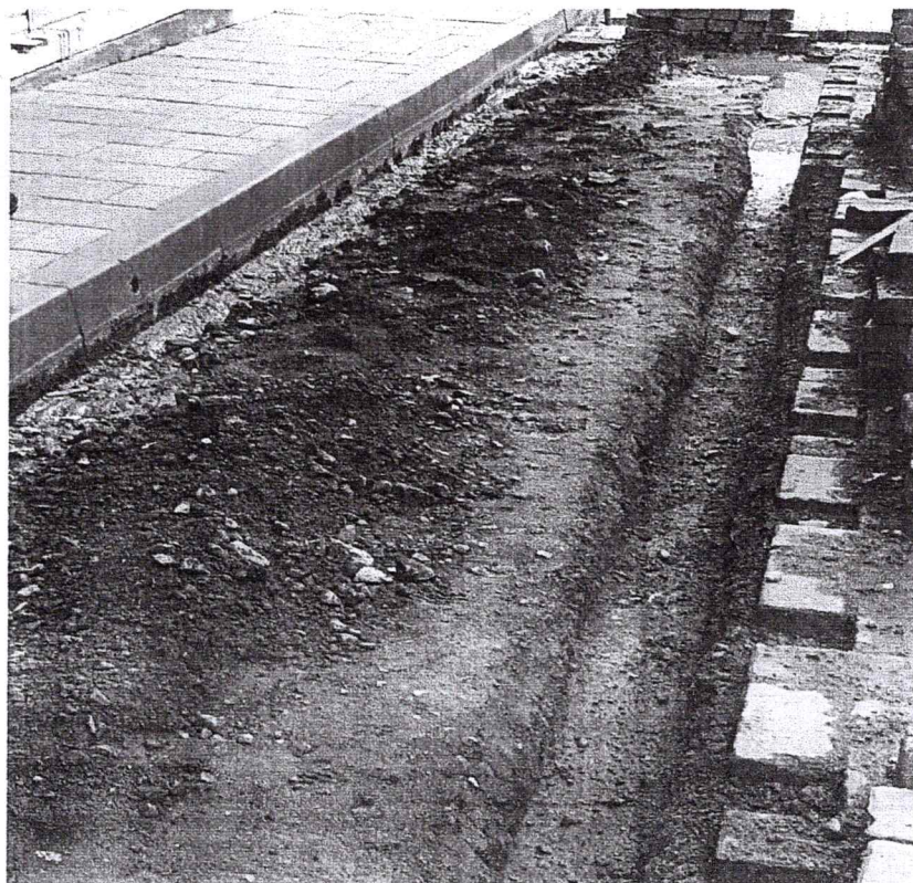
excavacion para bordillo y ensanche de acera
