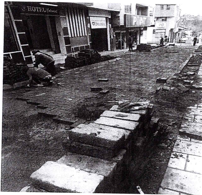
avance de colocacion adoquines
