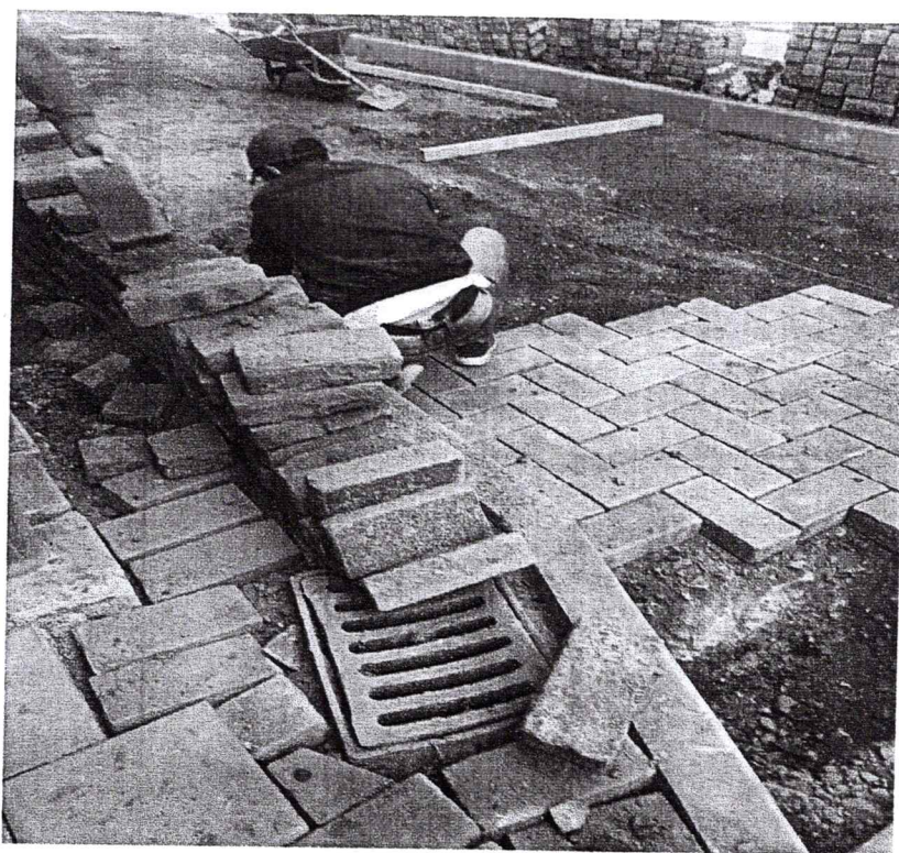
colocacion y nivalacion adoquines calle
