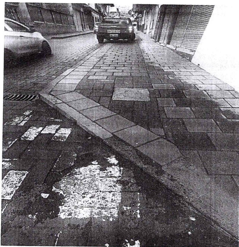
TERMINADO ACERA ESQUINA 10 DE AGOSTO
