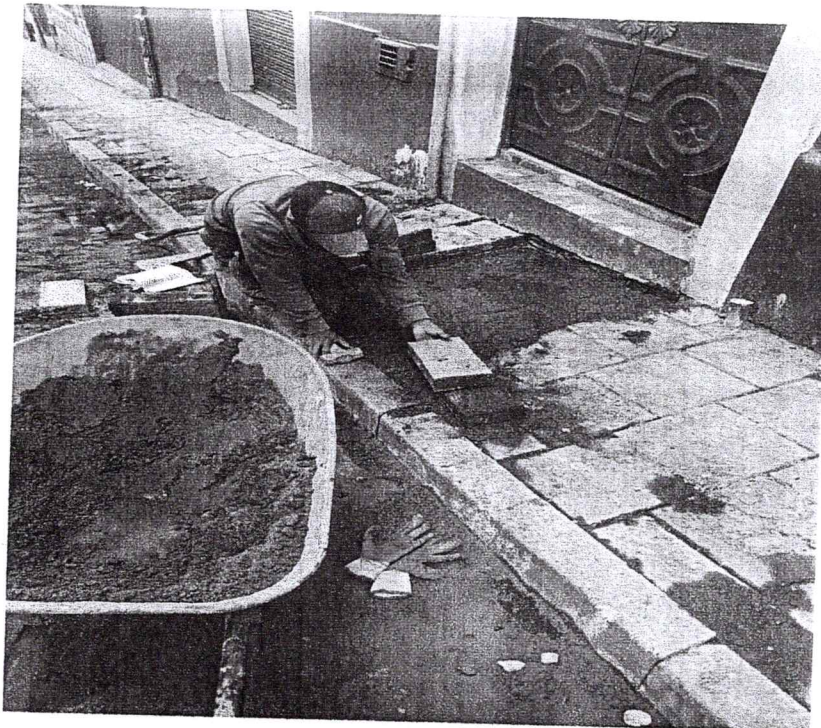
ARREGLO ACERA TRAMO SUR ENTRADA GARAJES Y LOCALES COMERCIALES
