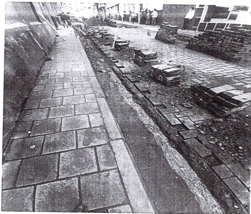
desmontaje de bordillos existentes
