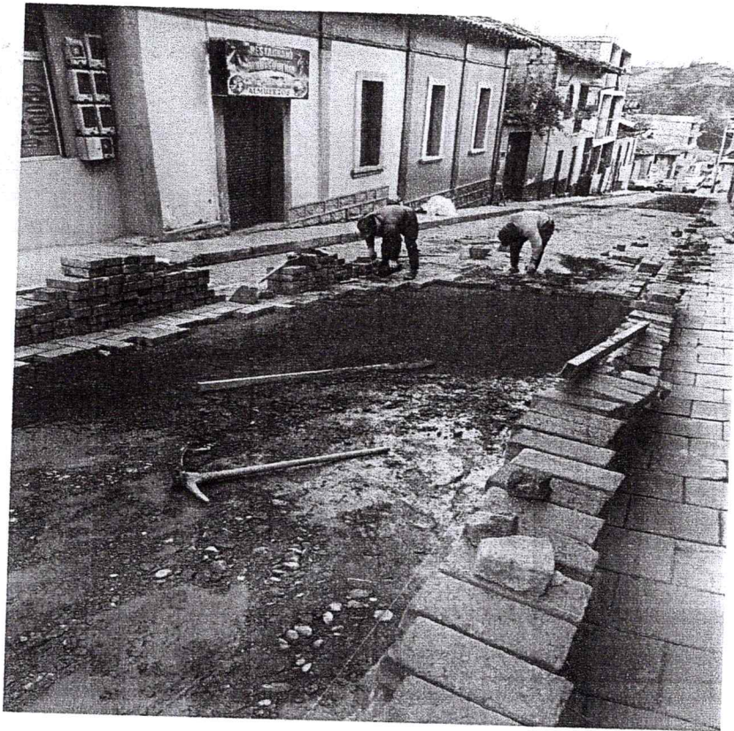
ARREGLO ADOQUINADO DOS TERCIOS DEL ANCHO DE LA VIA
