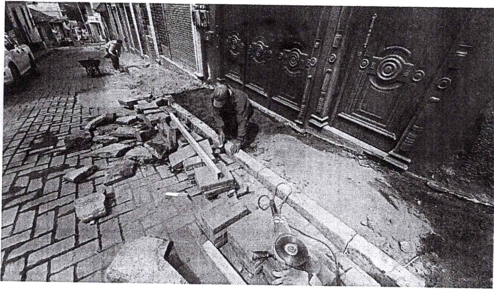
FOTOS OBRA ARREGLOS CALLE 9 DE ABRIL EN GUARANDA
