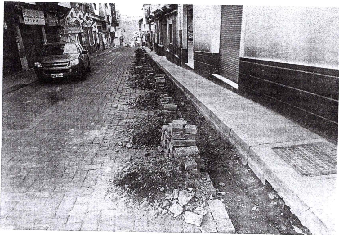
vista del inicio de los trabajos de remocion adoquin existente y de excavacion del ensanche de acera
