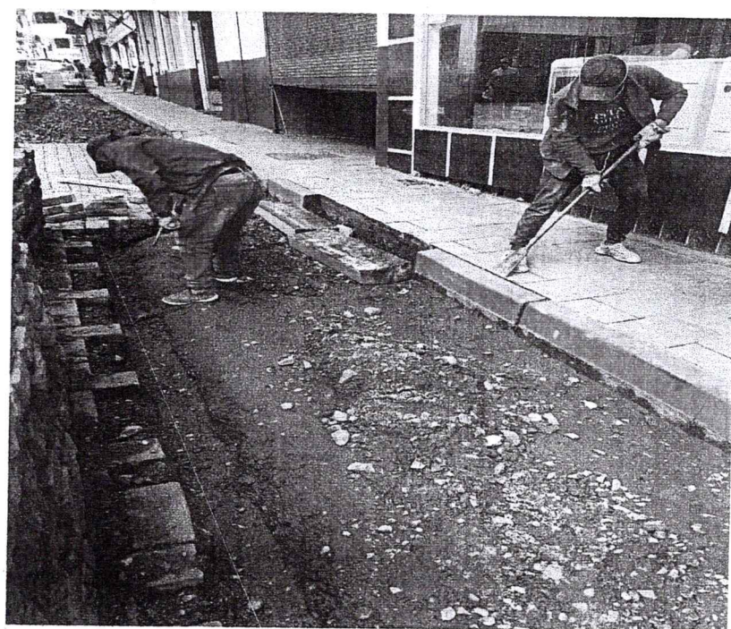
trabajos de desmontaje de bordillos existentes
