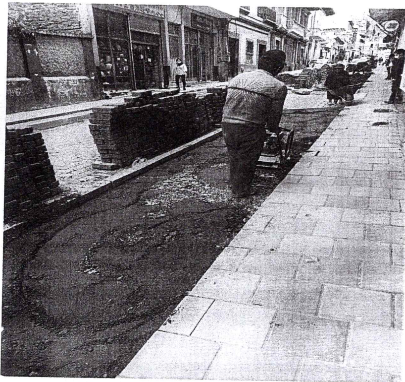
compactacion del lastre con vibroapisonador
