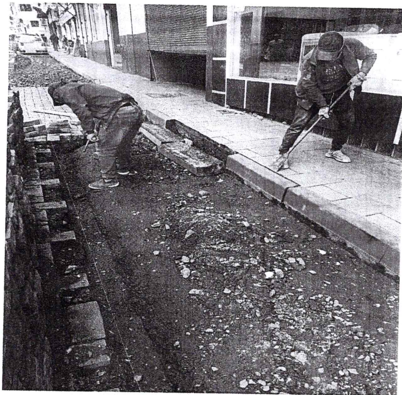
mas trabajos de ensanche acera nueva
