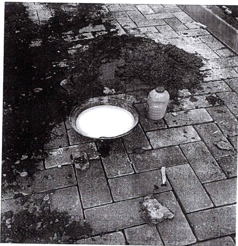
aditivo sikatop 77 para hormigon para asentar bordillos
