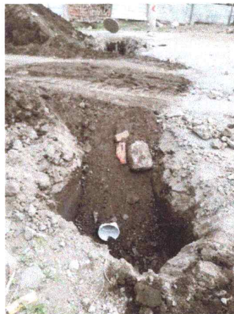
RUBRO: 02 RELLENO COMPACTADO
