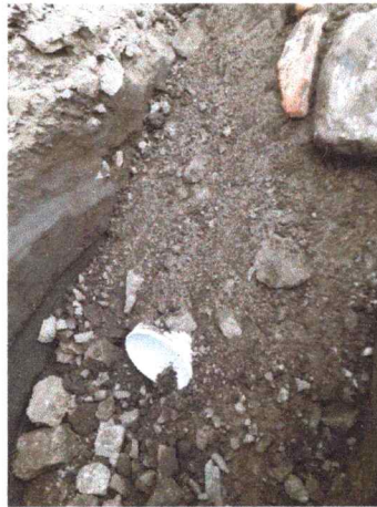
RUBRO: 02 RELLENO COMPACTADO
