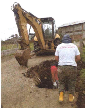
RUBRO: 01 EXCAVACION A MAQUINA
