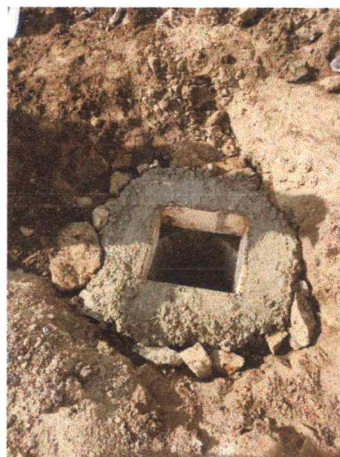
RUBRO: 03 – 04 ENCOFRADO – DESENCOFRADO – HORMIGON S. F' C 210 kg/cm2
