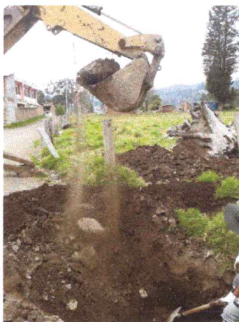
RUBRO: 01 EXCAVACION A MAQUINA
