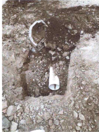
RUBRO: 02 RELLENO COMPACTADO
