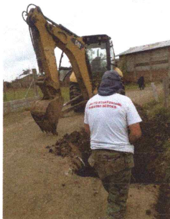
RUBRO: 01 EXCAVACION A MAQUINA
