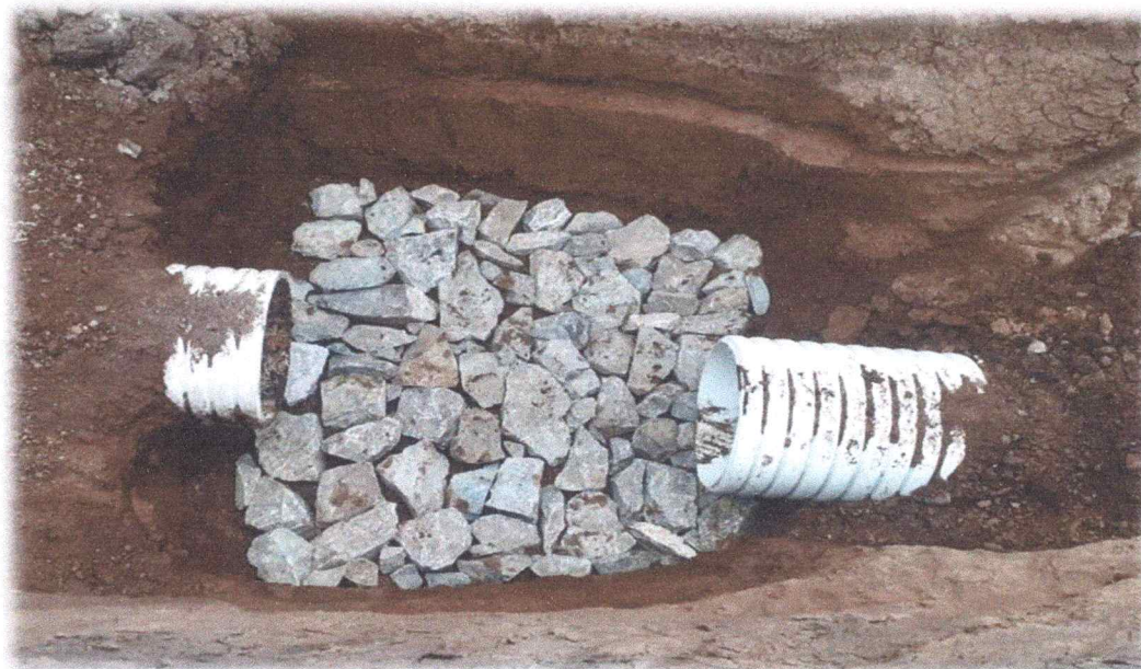
RELLENO CON MATERIAL DE MEJORAMIENTO (COMPACTADOR)
