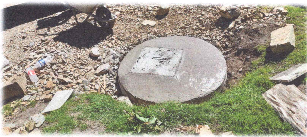
HORMIGÓN S. f'c=140 kg/cm 2 EN REPLANTILLOS
