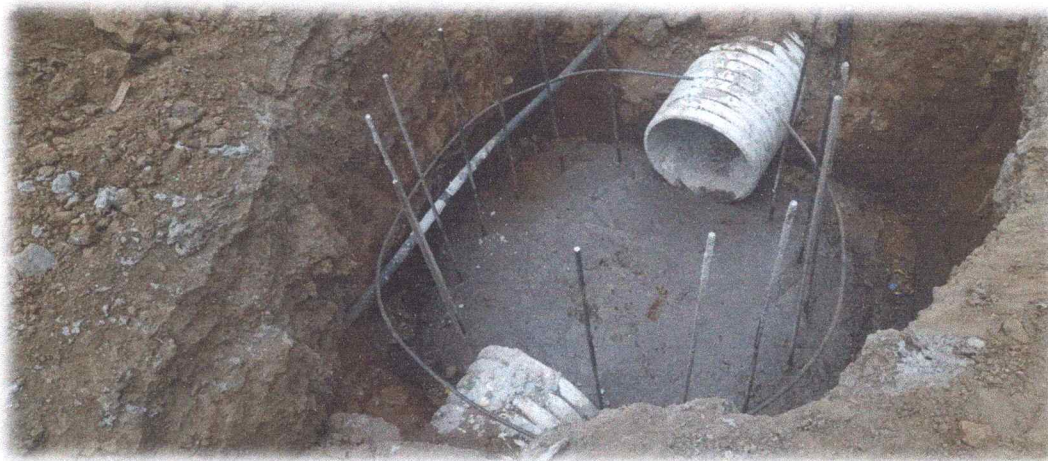
HORMIGÓN S. f'c=140 kg/cm 2 EN REPLANTILLOS
