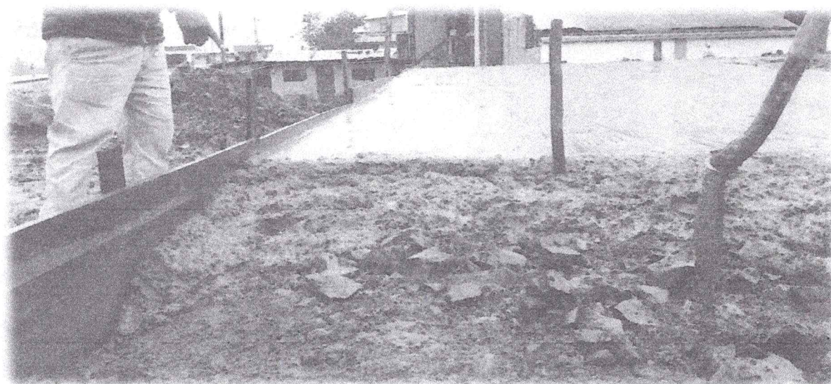
Fundición del muro hormigón ciclopeo y cancha hormigón simple
