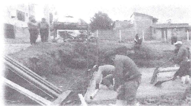
Encofrado perimetral de la cancha
