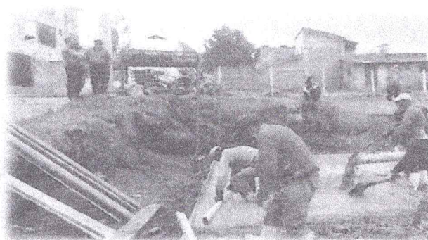
Encofrado perimetral de la cancha
