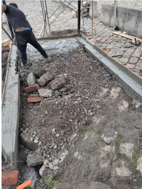
ENCOFRADO Y FUNDICION DE CADENAS
