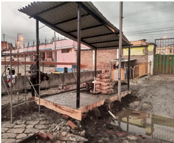
ENCOFRADO PARA CONTRAPISO
