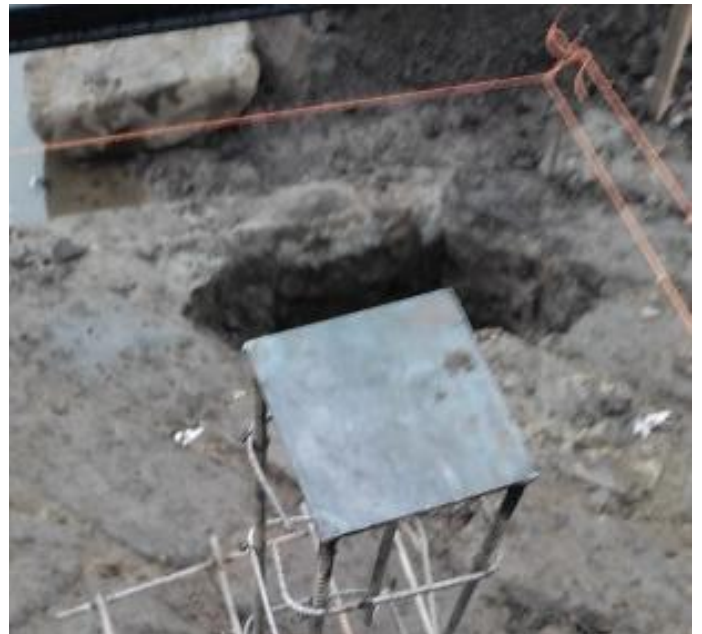
EXCAVACIÓN DE SUELO NATURAL
