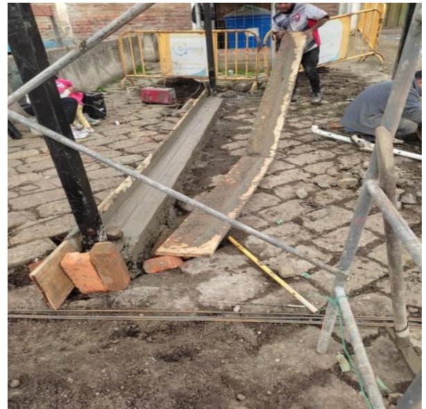
ENCOFRADO Y FUNDICION DE CADENAS
