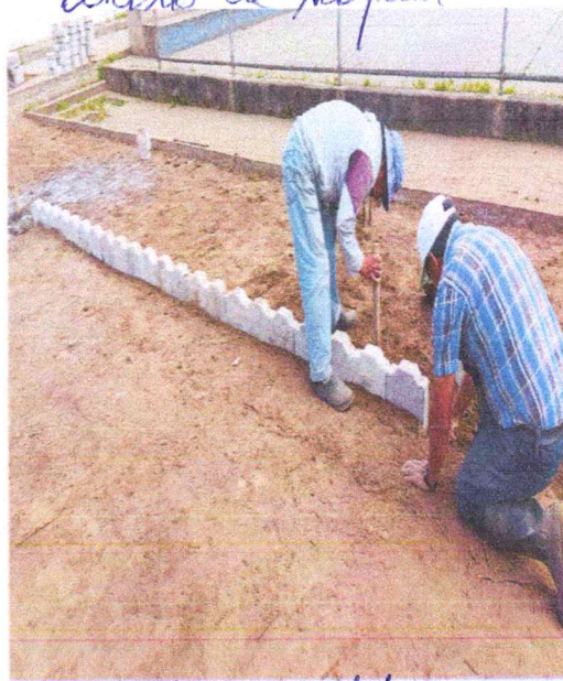
Bordillo con Adoquin Excavación de Terreno y Nivelación + /
