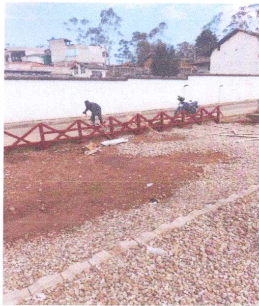
Colocada cerramiento Madera.
