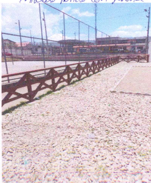
Nivelado de Terreno con Material Ripio-
