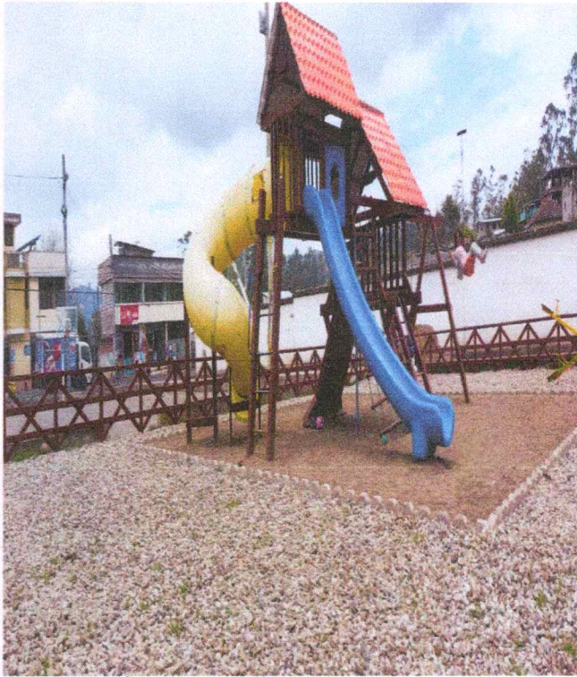
Nivelación de piso con Arena y Ripio.
