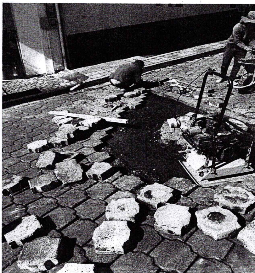
arreglo calle berma y adoquin esquina calle olmedo(FECAB)
