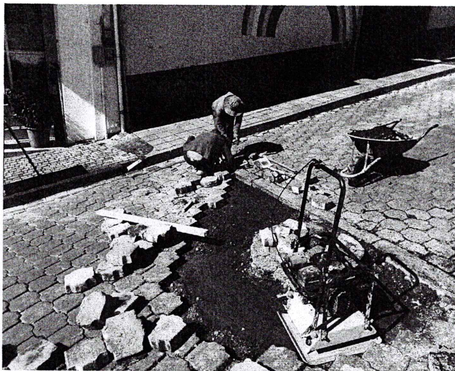
arreglo calle berma y adoquin esquina calle olmedo(FECAB)
