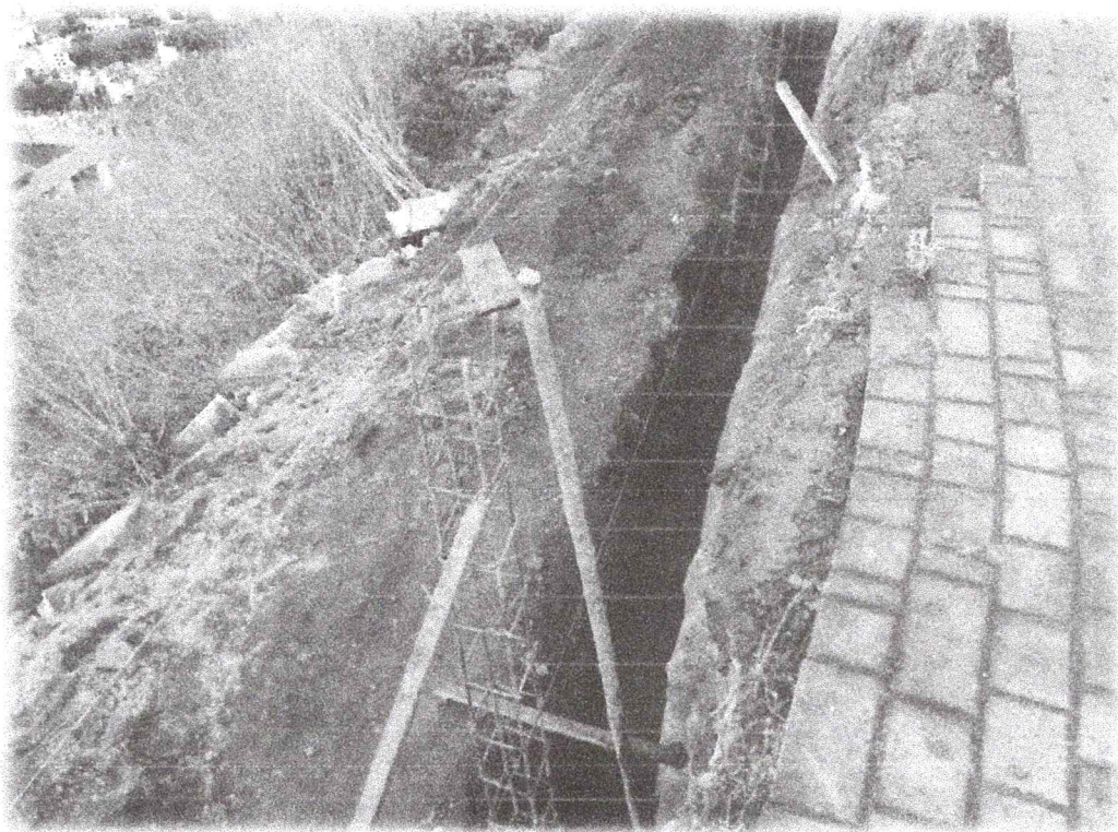
ARMADO DE COLUMNAS CON ACERO DE REFUERZO
