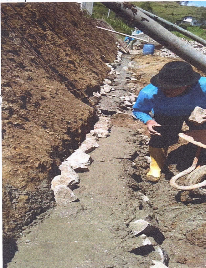
RUBRO: HORMIGON CICLOPIO NIVEL BAJO DE VIA
