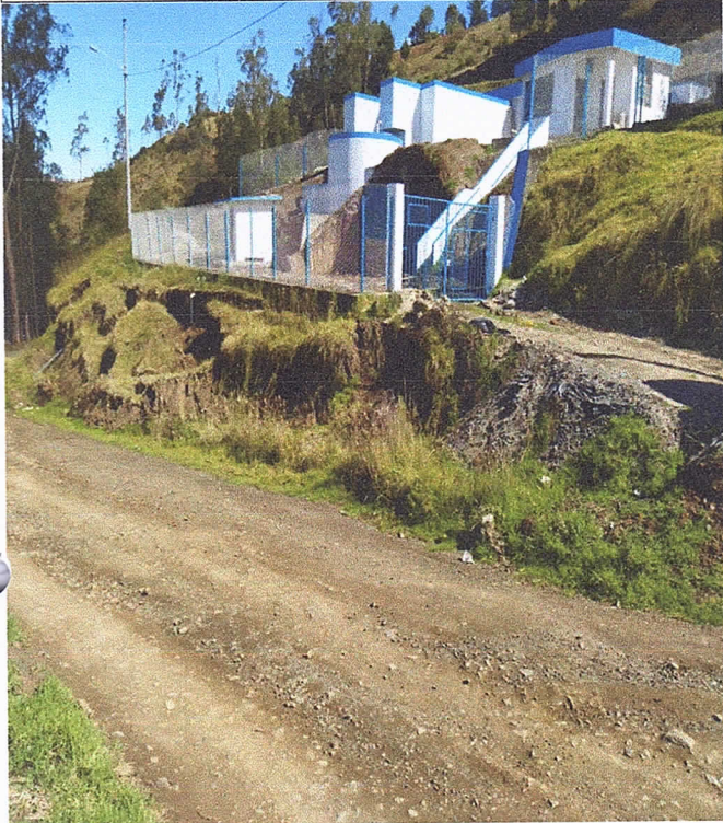
CONSTRUCCIÓN DE MURO ANTES
