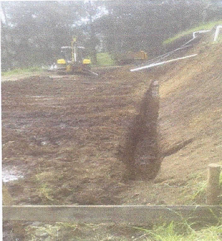
RUBRO: EXCAVACION SEQUIA NIVEL BAJO DE VIA
