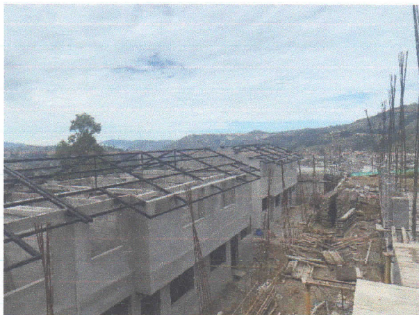
Armado de Cubierta
