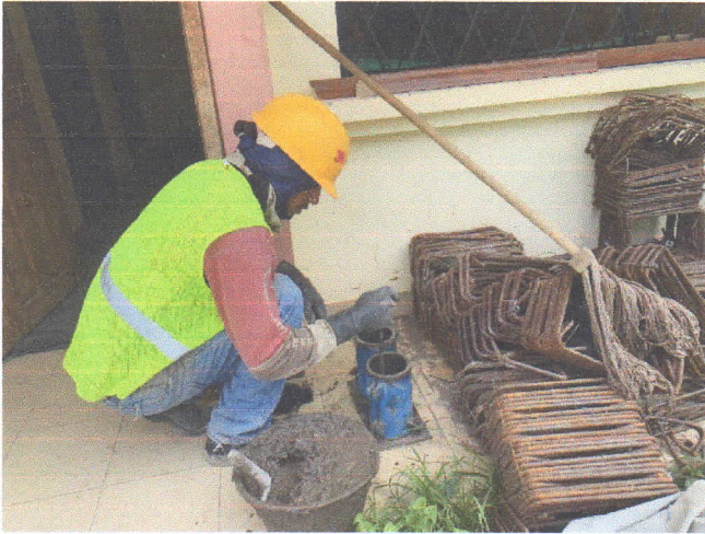
Toma de muestras de hormigón de loza
