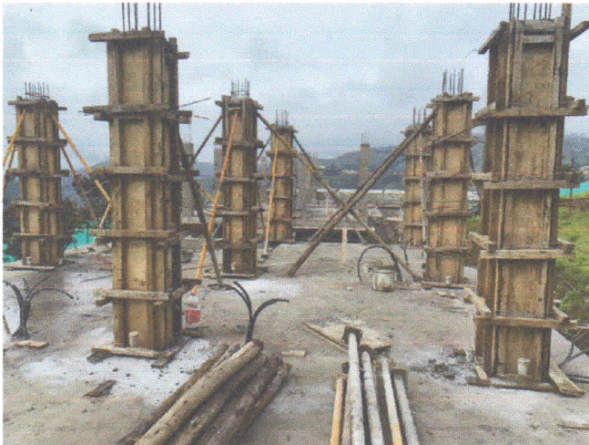
Encofrado y Fundición de columnas para la segunda planta
