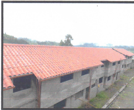
Entechado de las viviendas
