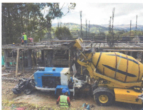
Fundición de la primera loza
