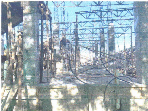
Armado de viguetas – encofrado de loza
