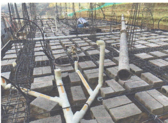
Colocación de bloque y tuberías de AA.SS.
