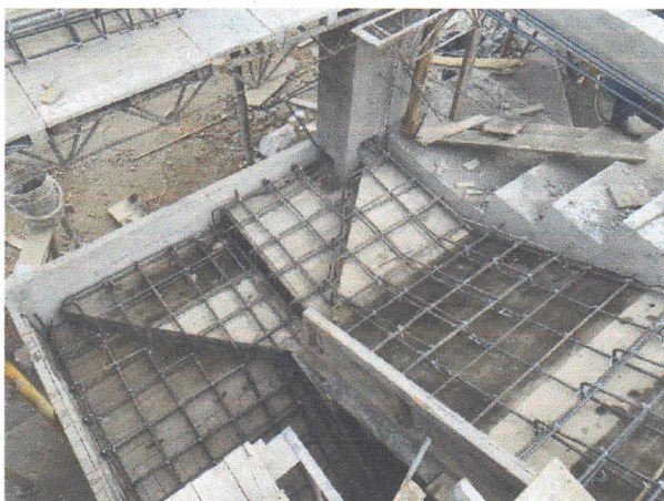
Armado de la grada
