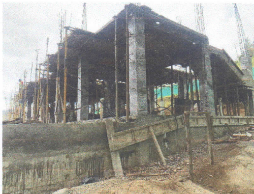
Encofrado para la loza
